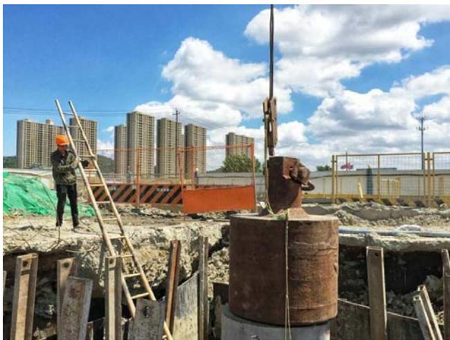
图1 高应变检测施工现场
