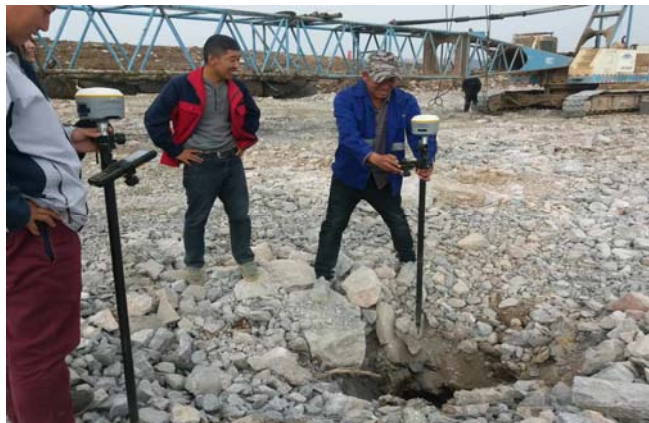
图3 外业人员正在利用GPS-RTK进行测量
