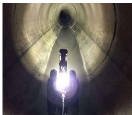
图3 排水管道实际检测
