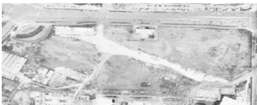
图1 莫土方平整区域利用无人机测量获取的影像图
