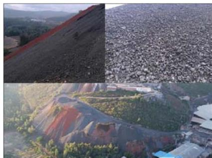
我公司实施的《个旧市冶炼废渣堆场原位风险防控技术示范项目》项目任务是原位处置位于云南省红河州个旧市某冶炼企业鼓风机炼铅产生的废渣,废渣量约300万吨,占地约65亩,渣体堆积高约90米,渣堆边坡为人工堆积自然滚落的陡坡,坡度约70%。项目技术方案是通过削坡整形、盖膜防渗、覆土绿化达到原位封存废渣和生态修复的目的。在
