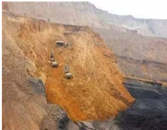
图5 矿山边坡隐患排查
